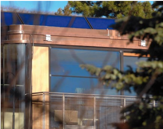
Solarkollektoren am Dach der Villa Massera.
