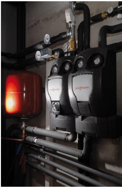
Hinter einer tapezierten Schiebetür – die Energiezentrale mit einer Sole/Wasser-Wärmepumpe.
