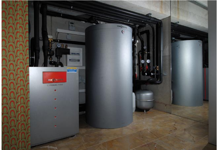
Hinter einer tapezierten Schiebetür – die Energiezentrale mit einer Sole/Wasser-Wärmepumpe.
